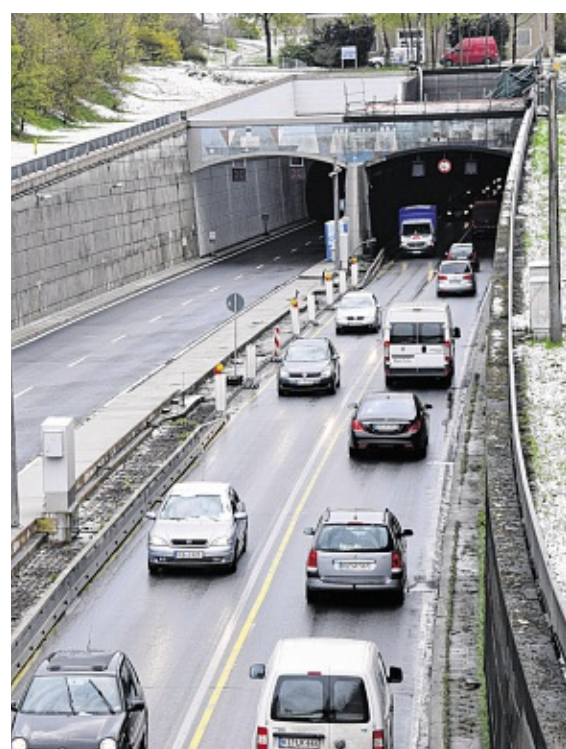
Blick auf den nördlichen Ausgang des Kanaltunnels, rechts die Weströhre. RASCHKE
